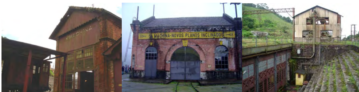
F7. Casa de máquina do 4º patamar, 2007. Foto da autora. F8.Casa de máquina do 5ºpatamar, 2005. Ingrid Wanderley. F9. Casa de força, caldeiras a vapor, 2007. Foto da autora.
