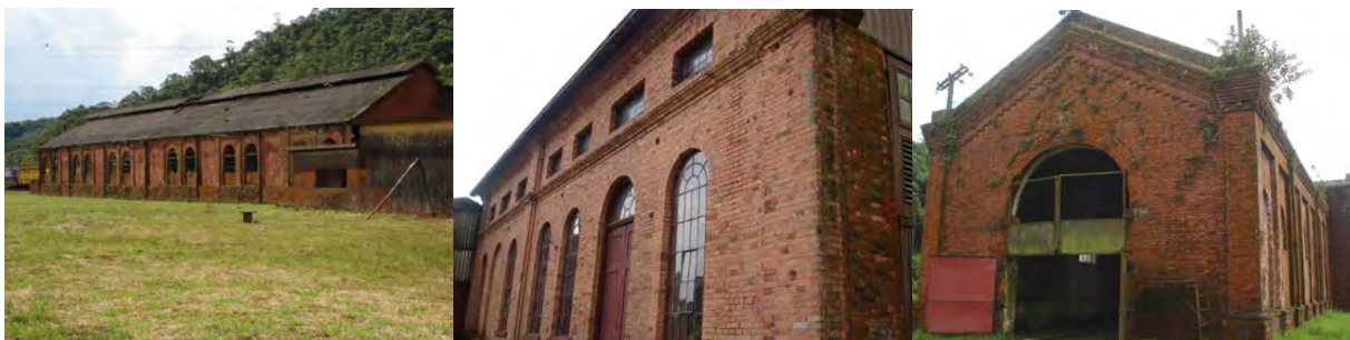
F10. Galpão ferroviário, 2005. F11 e 12. Detalhes construtivos, 2007. Fotos da autora.
