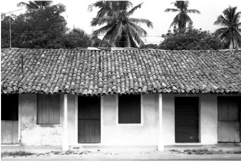
Figura 2. Casas de operários com galeria percorrendo as fachadas em Pontezinha, núcleo fabril erguido pela Pernambuco Power Factory a partir de 1866, em Pernambuco (Fonte: Acervo Pesquisa NUVILA, 1998)
