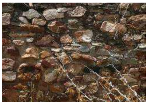
Fig. 52. Engenho Maraú – alvenaria mista de diversas rochas.
