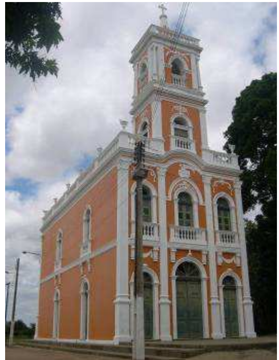
Fig. 64. Usina São João – Ecletismo como modernidade (CARVALHO, 2005).
