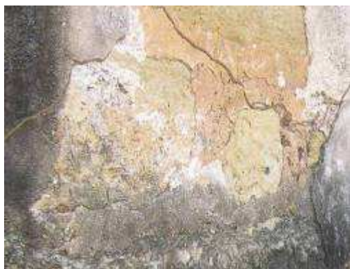
Fig. 50. Capela do engenho Gargaú – alvenaria de calcário da várzea principal.
