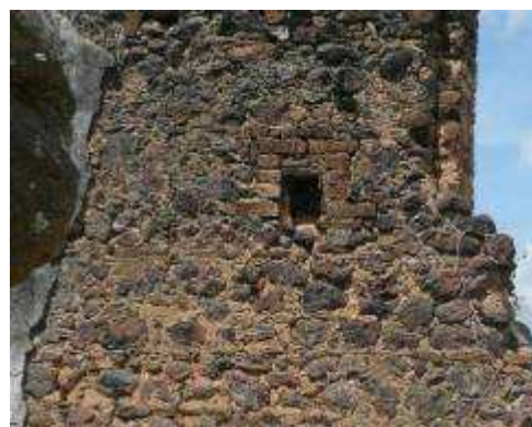
Fig. 51. Engenho São João – alvenaria de arenito ferruginoso típica da várzea principal.
