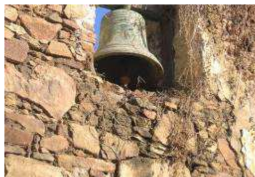
Fig. 53. Fazenda Consolação – alvenaria de diversas rochas (CARVALHO, 2005).
