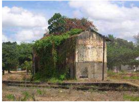
Fig. 66. Estação Engenho Central (CARVALHO, 2005).
