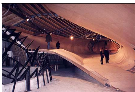
Figura 3 – A construção do Pavilhão Água. Fonte: Archined, 1997.
